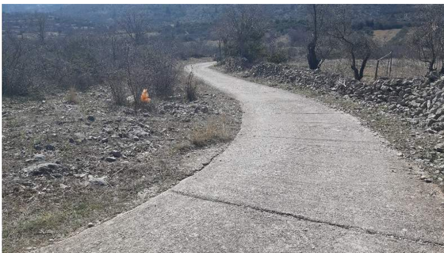
Slika 2. Pogled na prednji dio prometnice (zdrava postojeća betonska konstrukcija)
