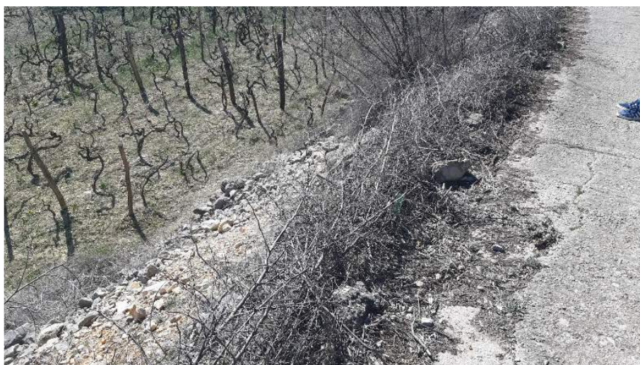
Slika 5. Pogled na postojeći pokos-izvedba zaštitne odbojne ograde
